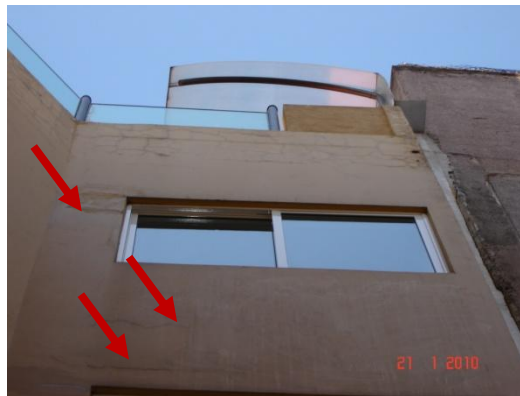
b) Muros nivel 3
