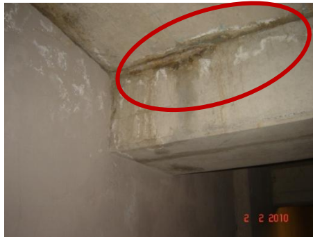
c) Trabes con daños por humedad
