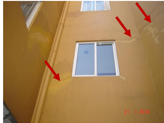
b) Muros nivel 1 y 2
