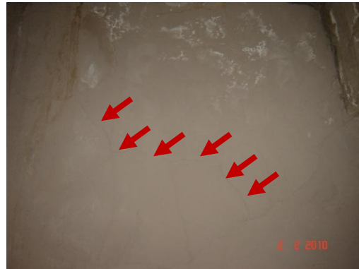
f) Grietas en elemento trabes, Sótano 1
