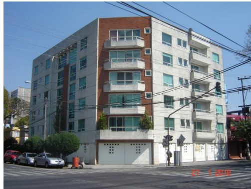
Figura 1. Vista Fachada principal
