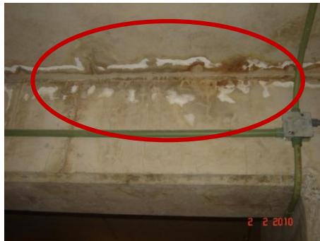
c) Trabes con daños por humedad
