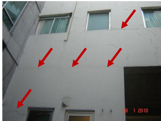
Muros de mampostería Planta Baja.
