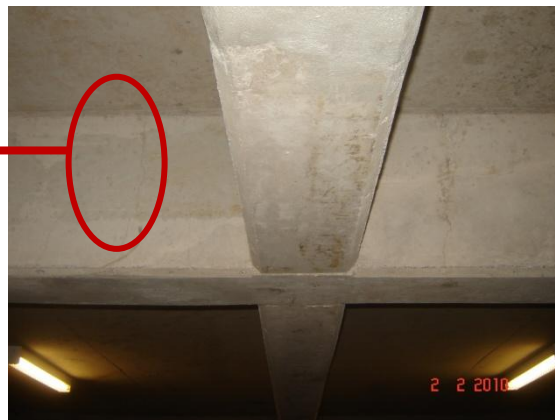
c) Trabes con daños por humedad
