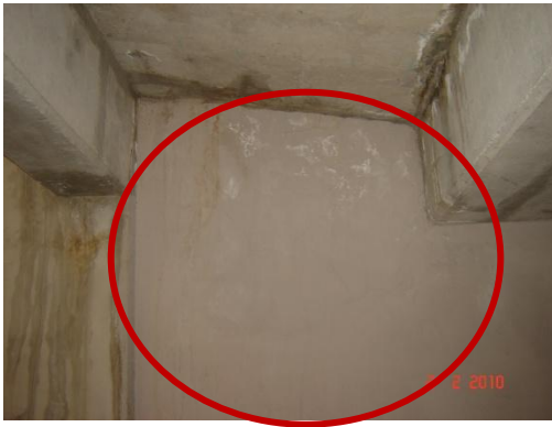
f) Grietas en elemento trabes, Sótano 1
