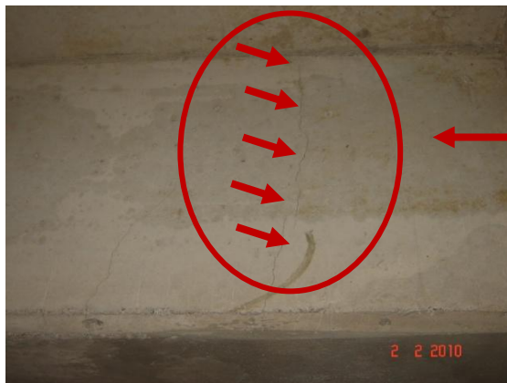
c) Trabes con daños por humedad
